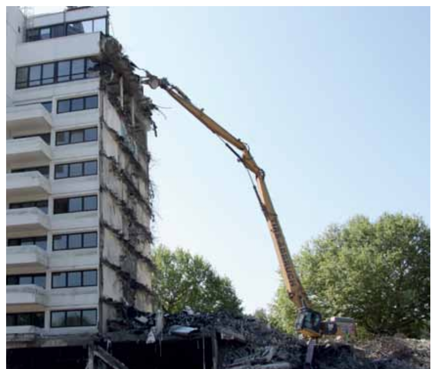
Auffällig: Der ultralange Ausleger am Cat 349EL ist der erste in Europa, um Bauhöhen wie die elf Stockwerke des Interconti-Hotels zu knacken.
