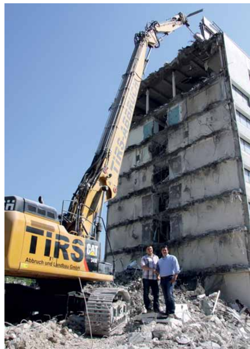
Die Baumaschine erreicht mit dem 29 Meter langen Ausleger und in Verbindung mit den Werkzeugen wie Greifer oder Schere 33 Meter.
